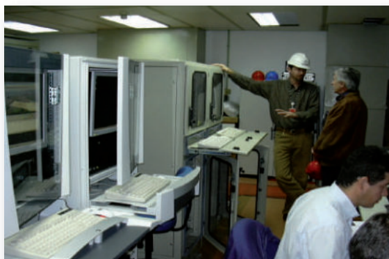
Sala de controle da barragem de ITAIPU
