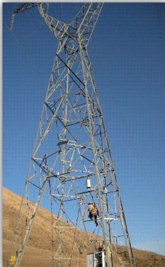
Medição de neve, Minera Alumbrera, Catamarca, Argentina
