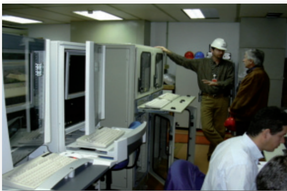
Sala de controle da barragem de ITAIPU
