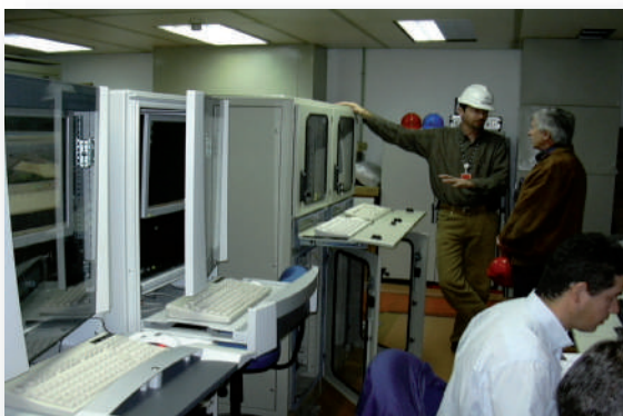
Sala de controle da barragem de ITAIPU
