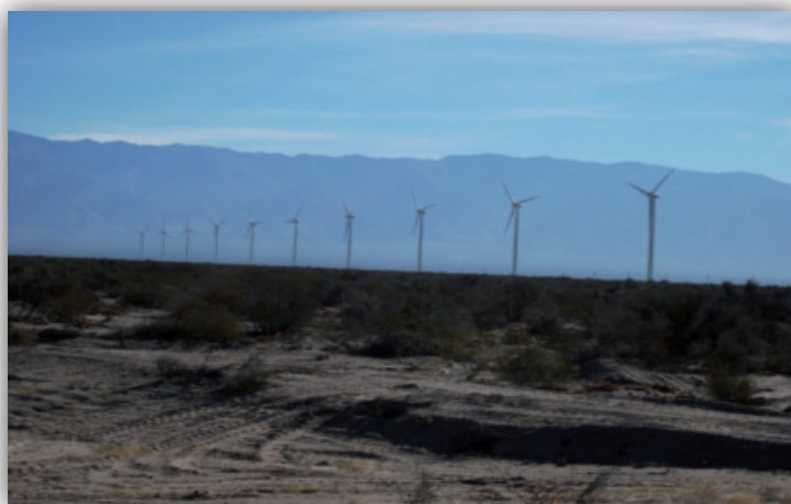
Campo de aerogeneradores, Catamarca, Argentina
