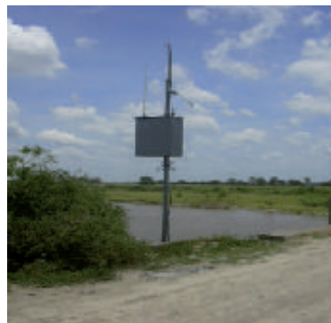
Control de niveles en el Río Salado, Provincia de Santa Fe, Argentina.
