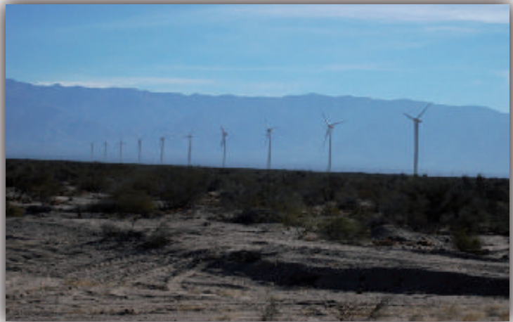
Campo de aerogeneradores, Catamarca, Argentina
