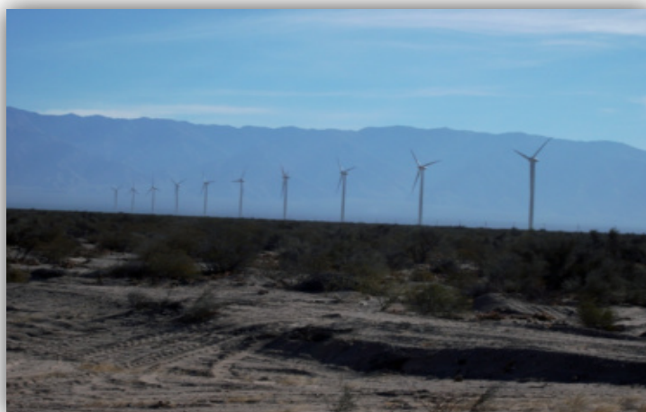
Campo de aerogeneradores, Catamarca, Argentina
