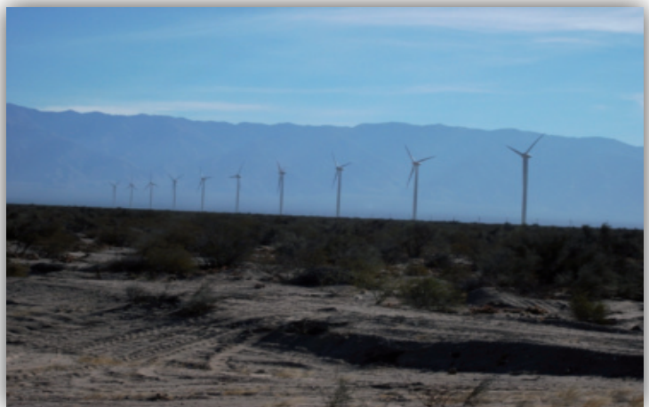
Campo de aerogeneradores, Catamarca, Argentina
