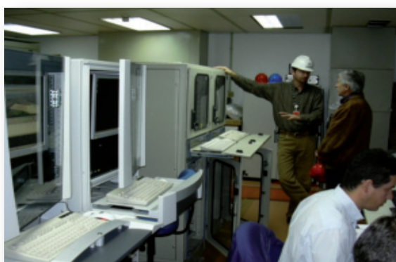
Sala de control de la Represa de ITAIPU
